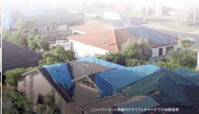
東日本大震災での岩手県陸前高田市の被害
