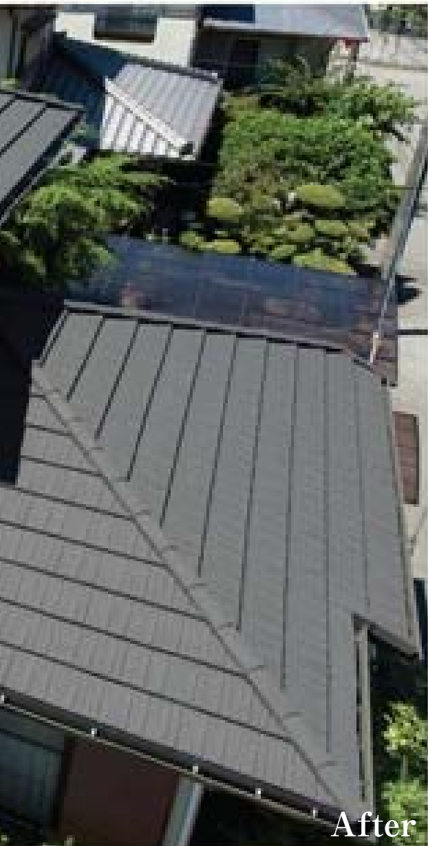
「デクラ屋根システム」施工後
